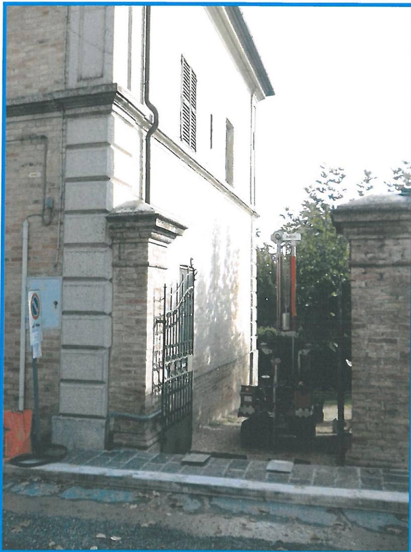
Figura 1) Esecuzione della prova DPSH
