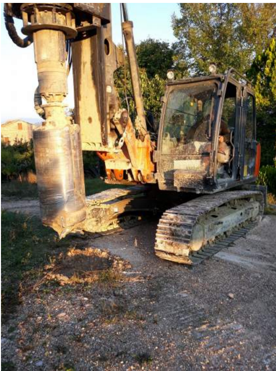
Postazione Sondaggio S3
